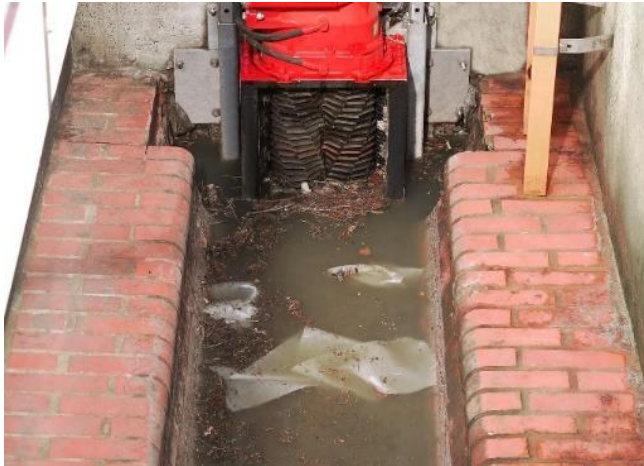
Afbeelding 1: De ripperrotoren versnijden materiaal in het afvalwater en beschermen zo de stroomafwaartse pompen en armaturen.
