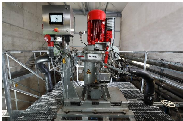
Bild 2: Der bewährte DisRuptor für die mechanische Desintegration lässt sich als Systemlösung schnell und unkompliziert nachrüsten.
