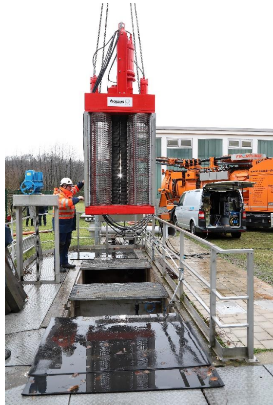
Bild 2: Der XRipper XRG186 beim Einbau in den Zulauf der Pumpstation Witten.
